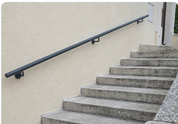
Escalier extérieur — contraste net avec le mur
